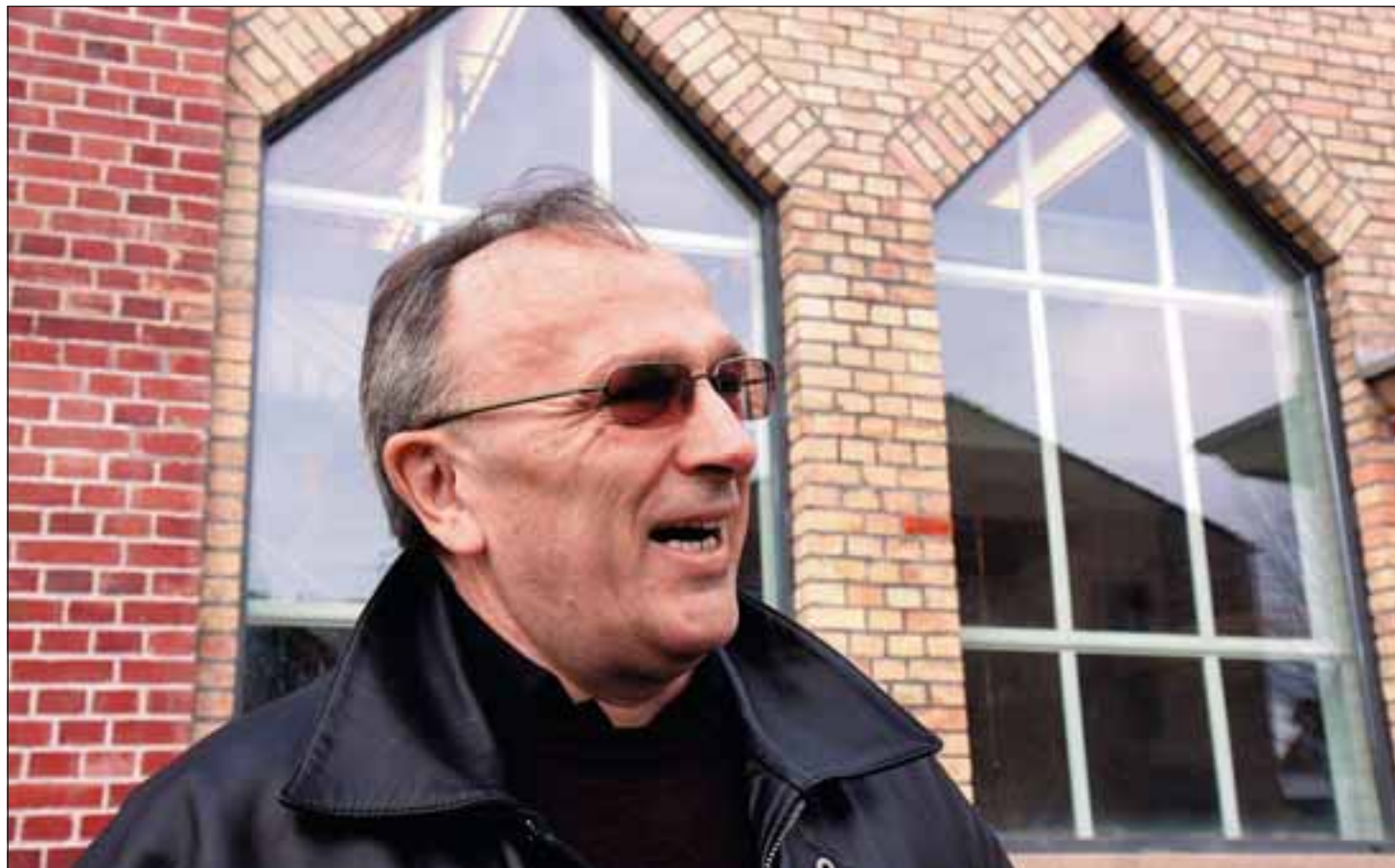
Freut sich auf die Eröffnung der neuen Alten Wollfabrik: Harald Zimmermann vor der denkmalgeschützten Fassade. Fotos: Norbert Lenhardt
