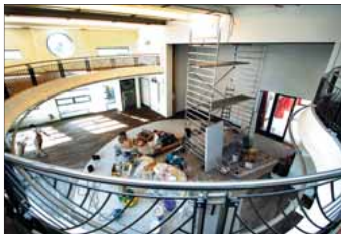
Blick ins Innere des Hauses, wo noch fleißig gewerkelt wird. Dass es ein Schmuckkästchen werden wird, sieht man aber bereits.
